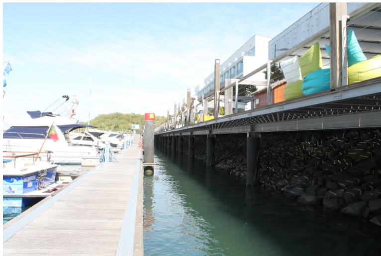
Figura 46 – Cais de amarração flutuantes e zona das esplanadas sobre estacas.
