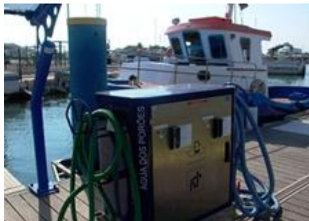
Figura 15 - Sistema pump-out Marina de Vilamoura (Fonte: www.marinadevilamoura.com ).
