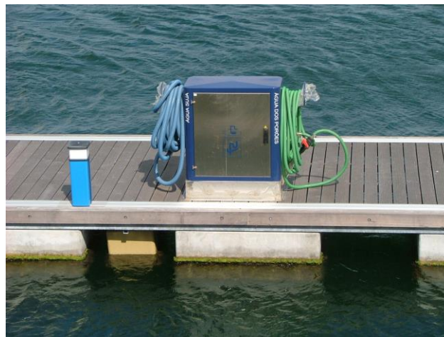
Figura 14 - Sistema pump-out TROIA MARINA.
