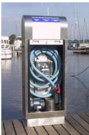
Figura 10 - Sistema pump-out no Porto de Roterdão (Fonte: www.seijsener.com ).
