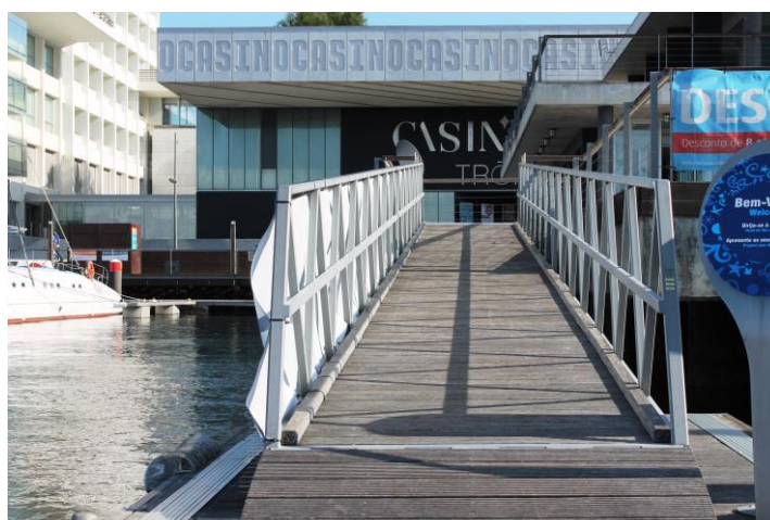
Figura 53 – Rampa de acesso à Marina.
