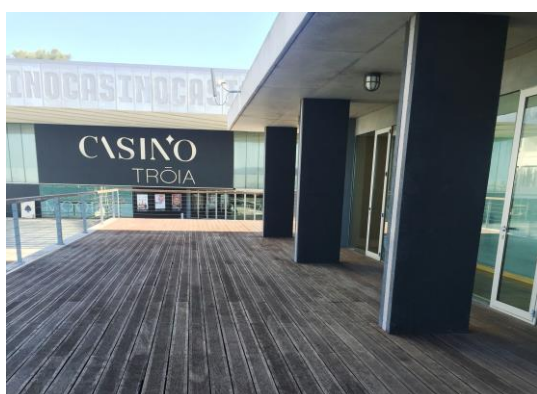
Figura 34 – Sombreamento exterior piso superior fachada este.
