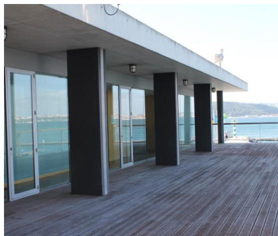
Figura 49 – Sombreamento exterior e vão envidraçados fachada este.
