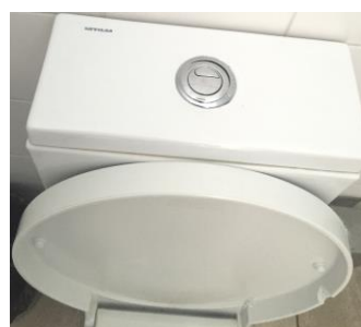
Figura 38 – Autoclismo de dupla descarga.
