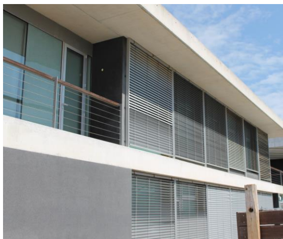
Figura 48 – Sombreamento exterior e estores fachada oeste.
